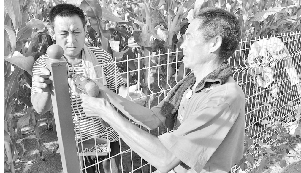
党建引领促蝶变,村庄旧貌换新颜,近日,嘉荫县保兴镇前景村着力加强农村基层党组织建设,采用“村里投资+村民集资”方式,将村里各家各户的木栅栏更换为统一的铁栅栏,使得农村环境不断提升,乡村振兴战略逐步落地生根。 图为施工人员进行安装铁栅栏。 本报记者 胡锡伟 摄
