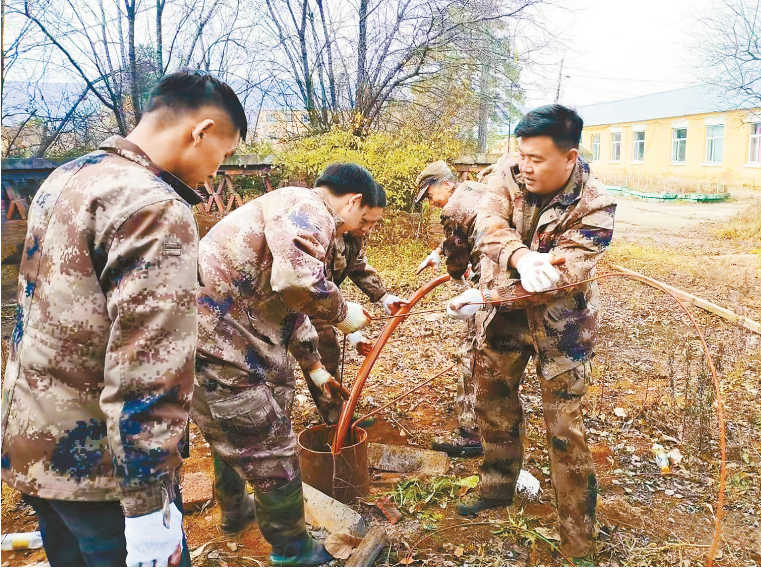
近日，伊春森工南岔林业局公司辖区内自来水泵房出现故障，无法供水。公司积极组织16名维修人员更换了水泵和电线、清理罐体、清洗了水管，经过3天的抢修，排除了设备故障，为辖区220户居民正常运转供水。
