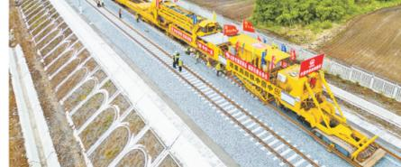
5月28日,中铁四局的工人在铁伊铁路二标段进行铺轨作业。 新华社记者 张涛 摄
